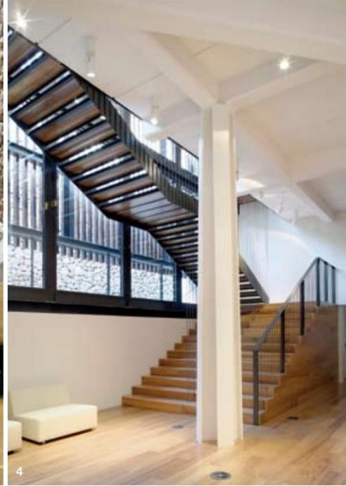
**1** La piscina arranca del interior. **2, 4 y 7** Gran parte de la superficie se encuentra bajo el nivel de calle. El techo de la planta -1, con el vestíbulo, es hormigón con jácenas colgadas. **3 y 6** El edificio se cubre dentro y fuera de piedra irregular, como el recorrido excavado que crea un paisaje artificial. **5 y 8** Las habitaciones se orientan al mar y se protegen con tablonés de canto, que también filtran la vista de la piscina del balcón.
