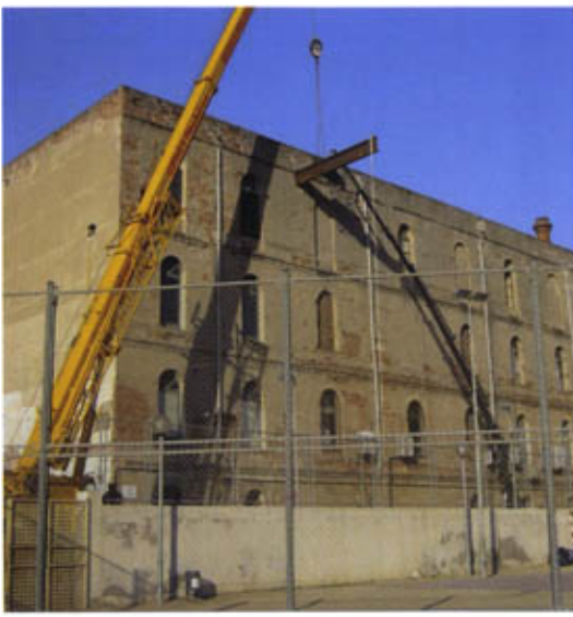
La instalación de un nuevo forjado permitió corregir las irregularidades del pavimento original.
