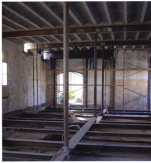
La instalación de un nuevo forjado permitió corregir las irregularidades del pavimento original.
