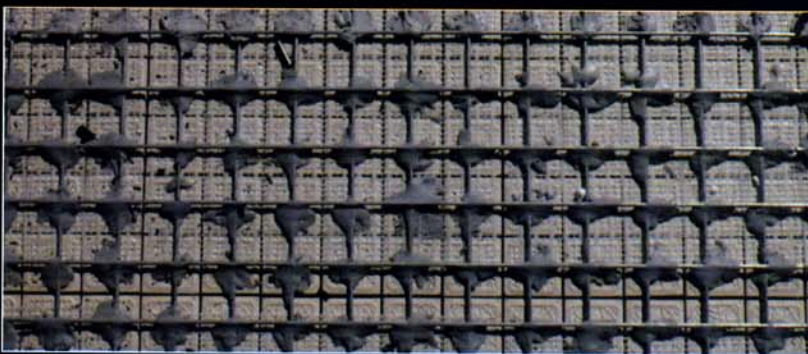
La subestructura está formada por malla de 5 x 5 cm a base de varillas de 4 mm electrosoldadas.
