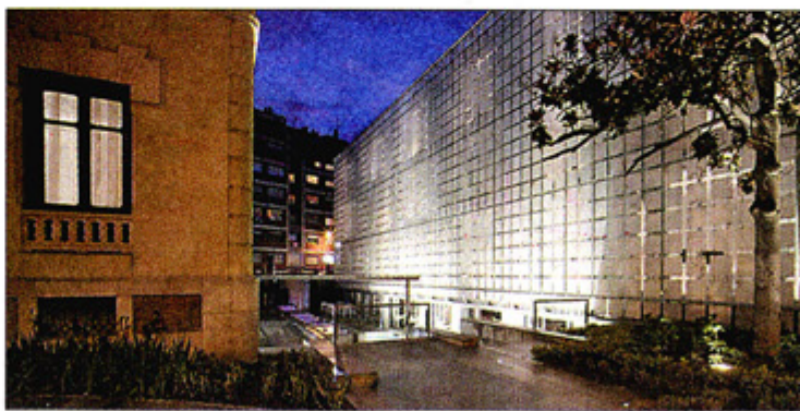
La ampliación del Hotel Hospes Palacio de los Patos, en Granada y el edificio original.
